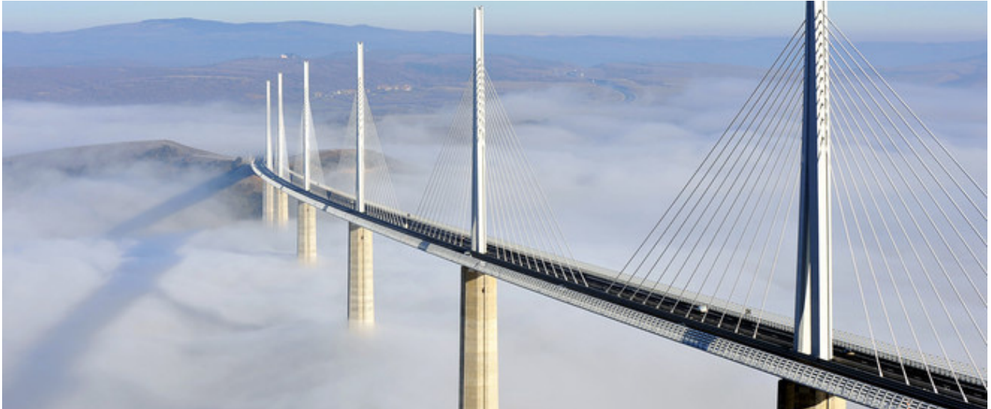
The Millau Viaduc (Millau, France, 1993 - 2004) © photo : Daniel Jamme/Eiffage
